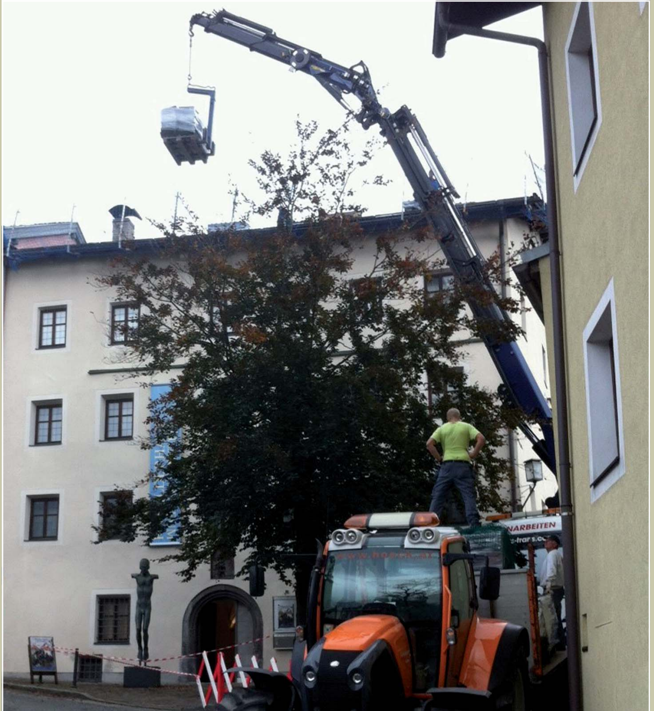
Sanierungsarbeiten im Rabalderhaus
