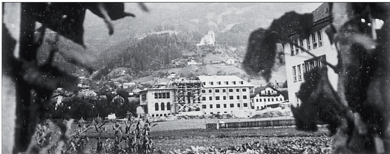
Das Altersheim der Barmh. Schwestern kurz vor der Fertigstellung etwa 1960; daneben rechts der Hof »Unterweidach«.
