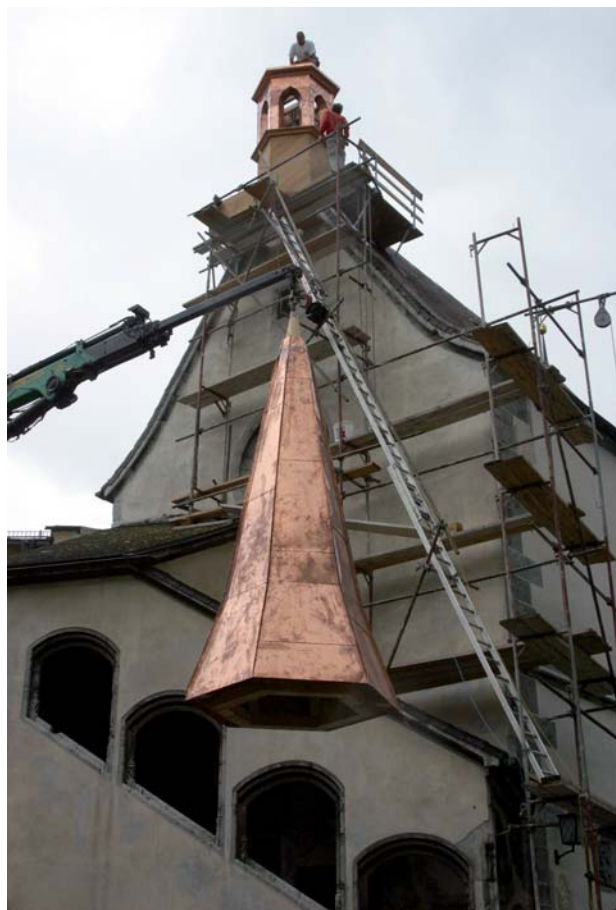
Aufsetzen des rekonstruierten Giebelreiters, 2004, Foto Ing. Manfred Kljma
