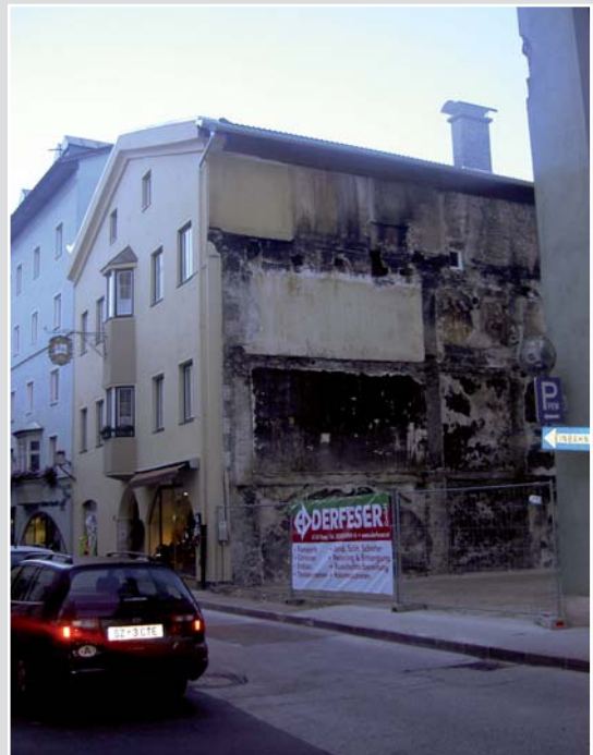
D ie Baulücke nach dem Abriss Ende Oktober 2007.
