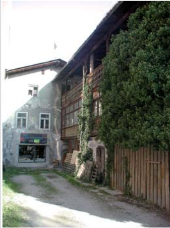
K lingenschmid-Haus zur Innseite mit Veranda (erbaut um 1880) um 2002 aufgenommen.
