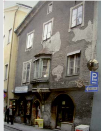
D as originelle Geschäfts- haus Klingenschmid (Lassner) in der Innsbrucker- straße vor dem Brand.
