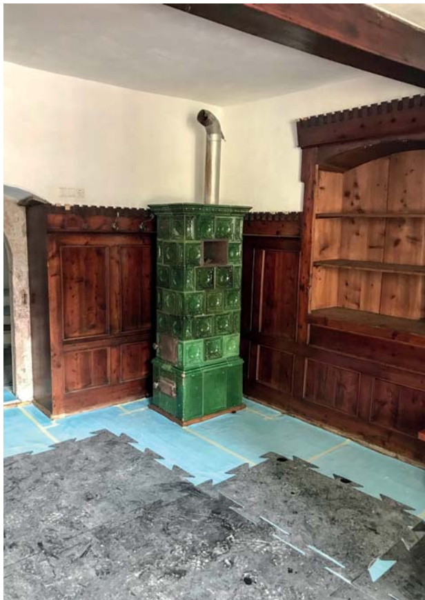
Gaststube während der Renovierung.
