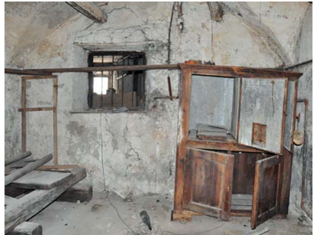
Ursprüngliche, spät-gotische Fensteröffnung.
