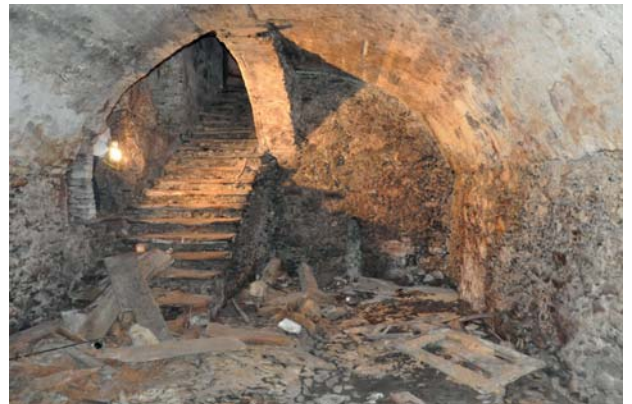
Großer Kellerraum mit Tonnengewölbe.
