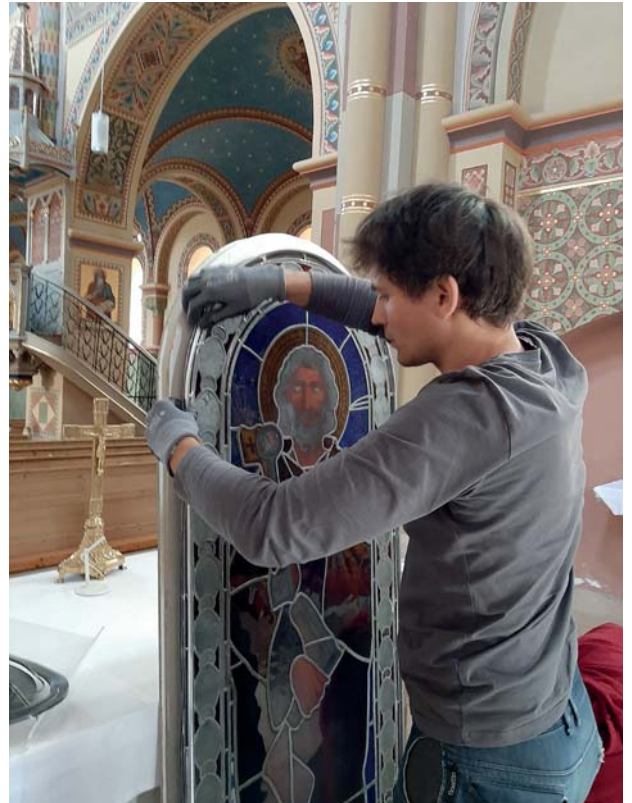
Thomas Medicus bei der Vorbereitung für das Einsetzen der Glasmalereifenster im Presbyterium am 26. Mai 2020
