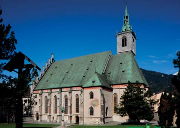
Schwaz, Pfarrkirche Maria Himmelfahrt mit Kupferdeckung am Turm- und Kirchendach.
