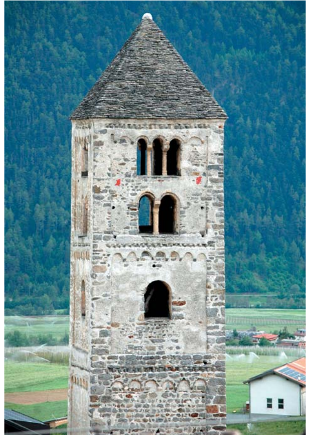
Mals, Kirche St. Johann mit gemauertem Pyramidenhelm mit Steinplattendeckung. Foto: Martin Laimer, Lana
