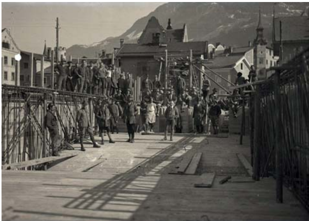
Arbeiter der Brücke
