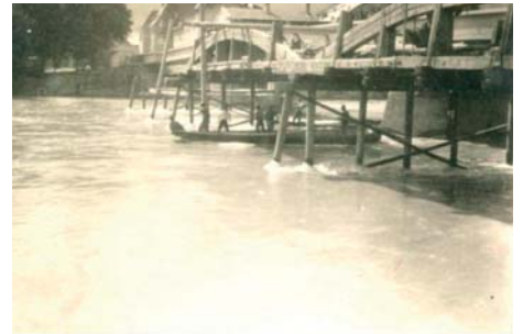
Abbau der Holzbrücke
