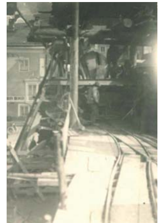
Betontransport mit Gleiswagen
