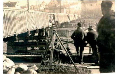
Vorbereitungsarbeiten zum Brückenverschub
