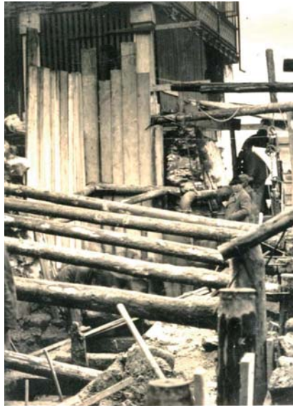
Widerlager Fundament bei Gasthaus
