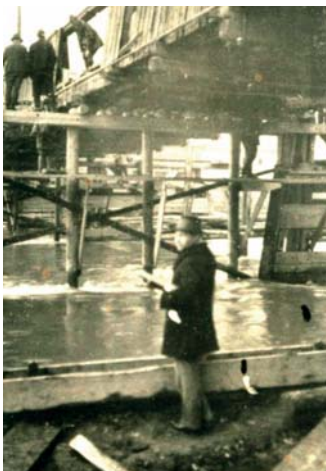
Brücke beim Umsetzen
