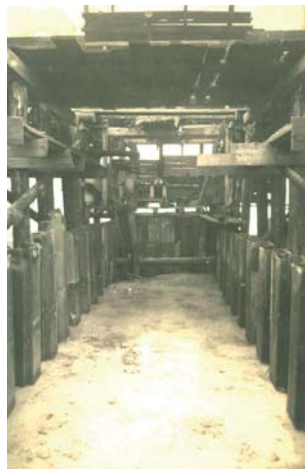
Betonierung eines Pfeilers
