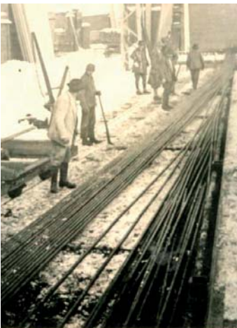
Stahl wird händisch abgeladen
