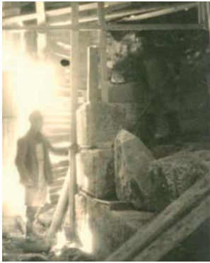
Mauern der Brückenpfeiler
