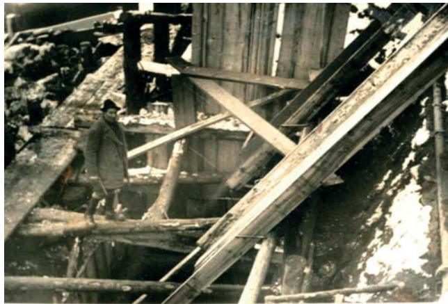
Fundament betonieren über Holzrutschen
