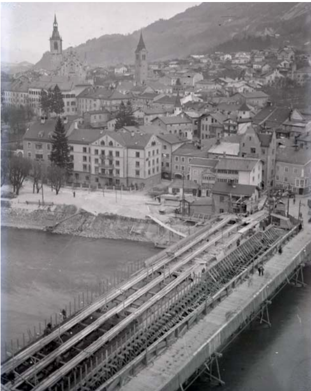
Die Behelfsbrücke mit Neubau der Steinbrücke
