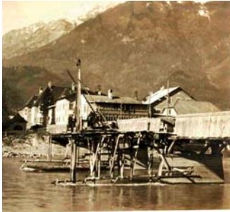
Vorbereitungsarbeiten für Ersatzbrücke Neue Pfähle zum Verschieben
