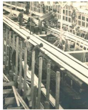
Betonierung über eine Gleisanlage
