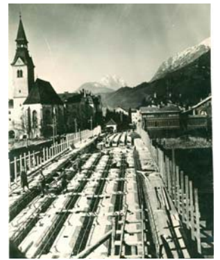
Schalungskörper entlang der Träger
