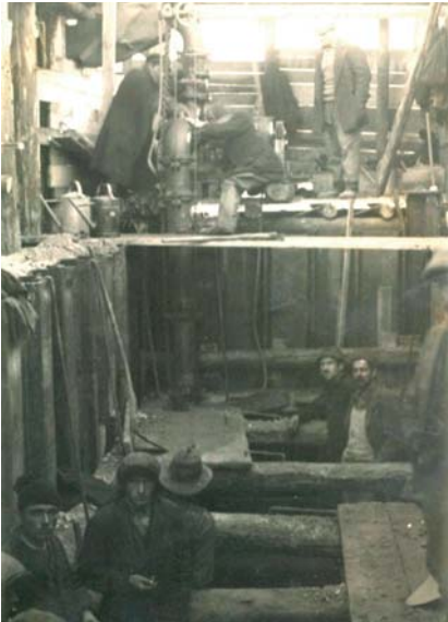
Händischer Aushub des Fundaments
